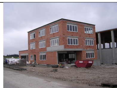
Das ABZ-Steyrtal – Baufortschritt vom 4. August.
